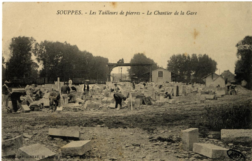
Fig. 5.18 : Chantier de taille à la gare de Souppes sur Loing (Document AD 77: 2FI 22871)
