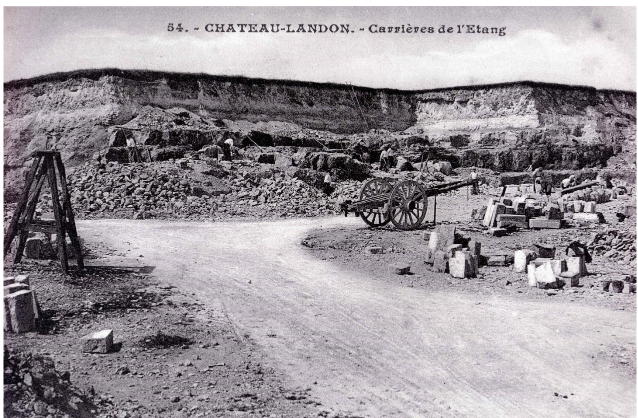
Fig. 5.17 : Vue générale d'une carrière de calcaire vers 1900 : Carrière de l'Etang à Château-Landon. Au 1er plan blocs taillés et charrette de transport, au 2ème plan : fronts de taille et ouvriers
