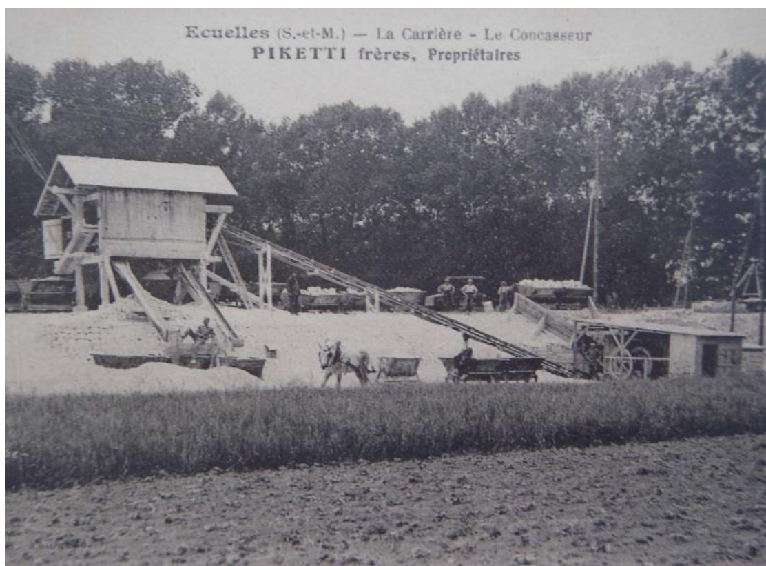
Fig. 7.19 : Vue de la Carrière d'Ecuelles- Sté Piketty Frères vers 1925 : le concasseur et son système d'alimentation
