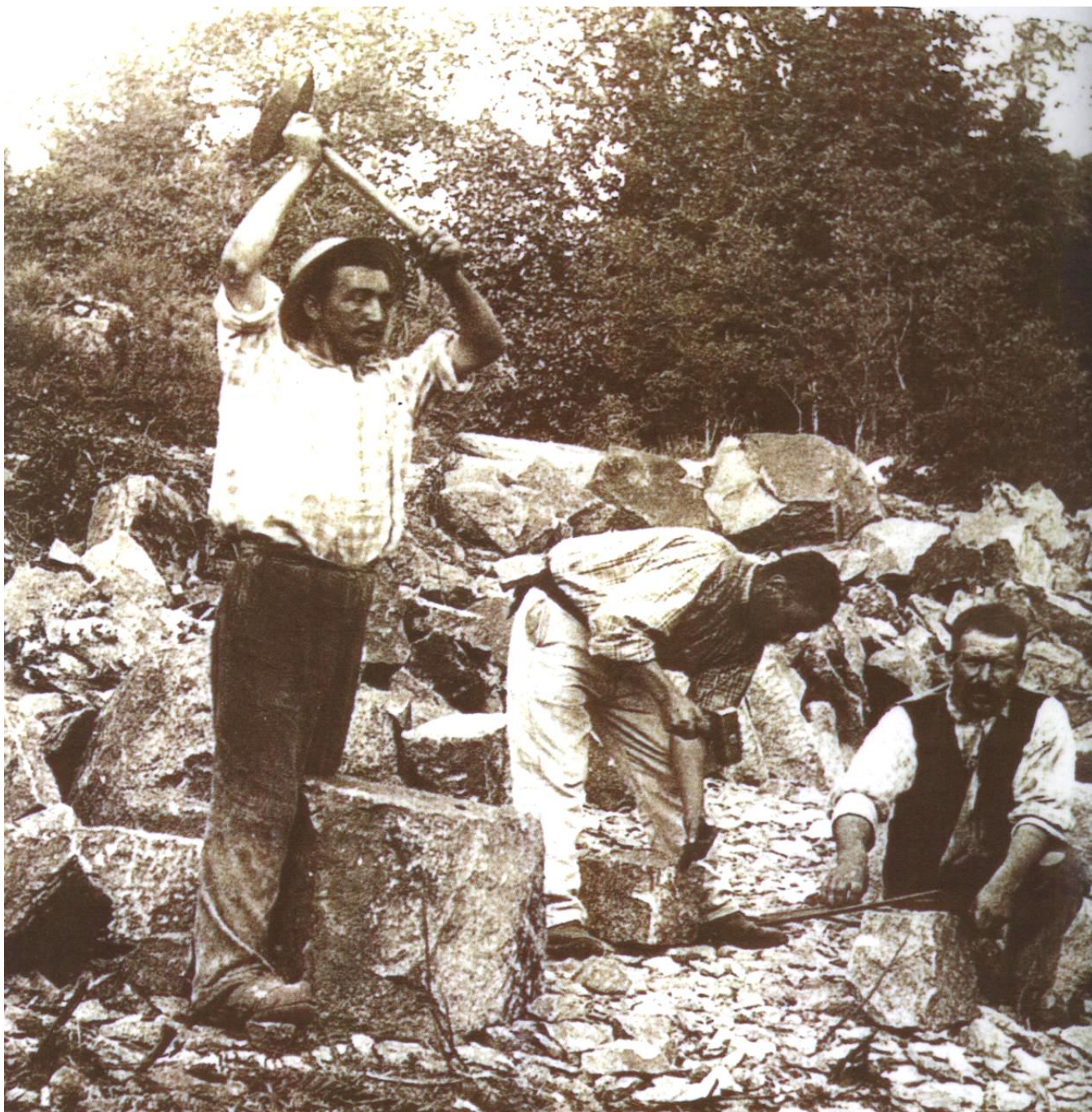
Fig. 9.13 : Vue du travail en carrière avec le « têt »
