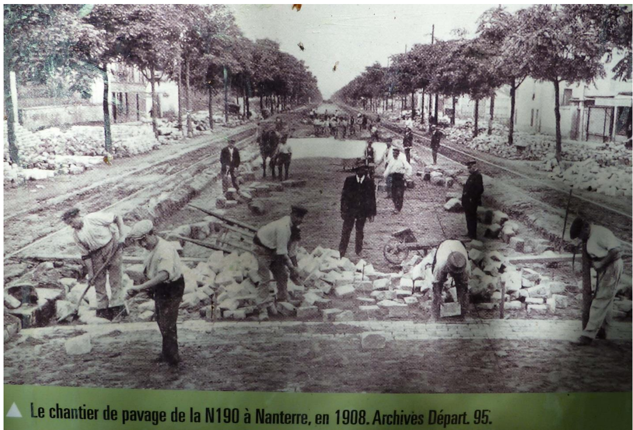
Fig. 3.65: Opération de pavage en grès de Fontainebleau à Nanterre en 1908 (Document Jean Pillot, AFF)
