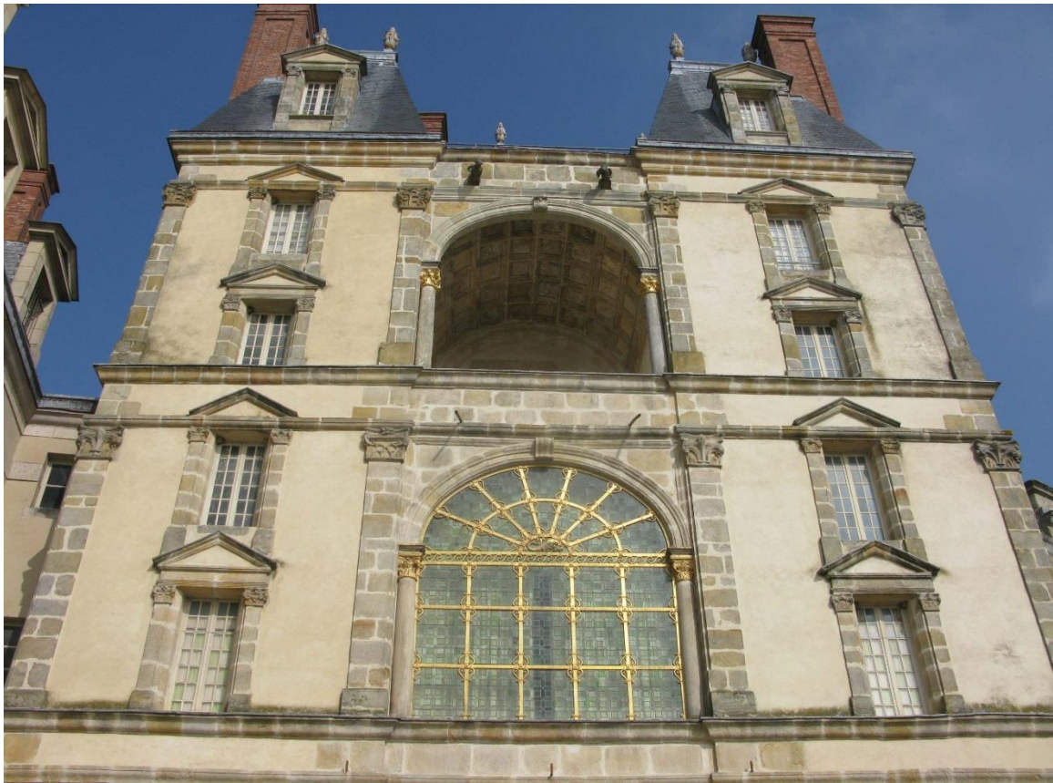
Fig. 3.66: Façade de la Porte Dorée du Château de Fontainebleau : édifée à partir de 1528, on remarque l'utilisation du grès pour les chaînages d'angle à chaque extrémité de la façade, pour les pilastres et les corniches (parties foncées de la façade) (Document : Prof. Patrick Dubreucq : travail des élèves de Seconde-Lycée Blanche de Castille , mars 2012)
