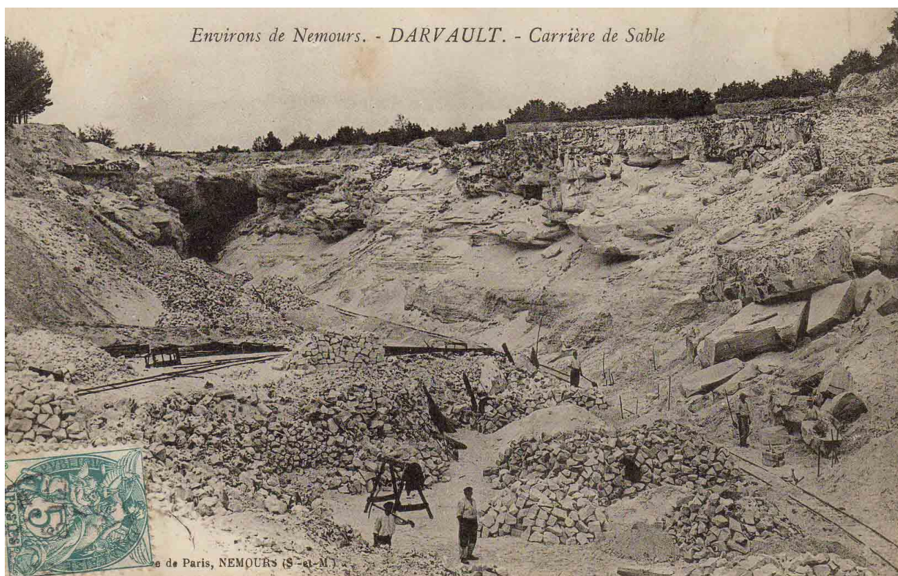
Fig. 4.8.4: Vue des Carrières de sables et grès de Fontainebleau de Darvault vers 1900. Dans le coin gauche en haut, entrée de la carrière souterraine, sous la dalle de grès. On note aussi l'utilisation de rails à voie étroite de type Decauville pour la sortie des matériaux (Document AD 77 2FI21215)
