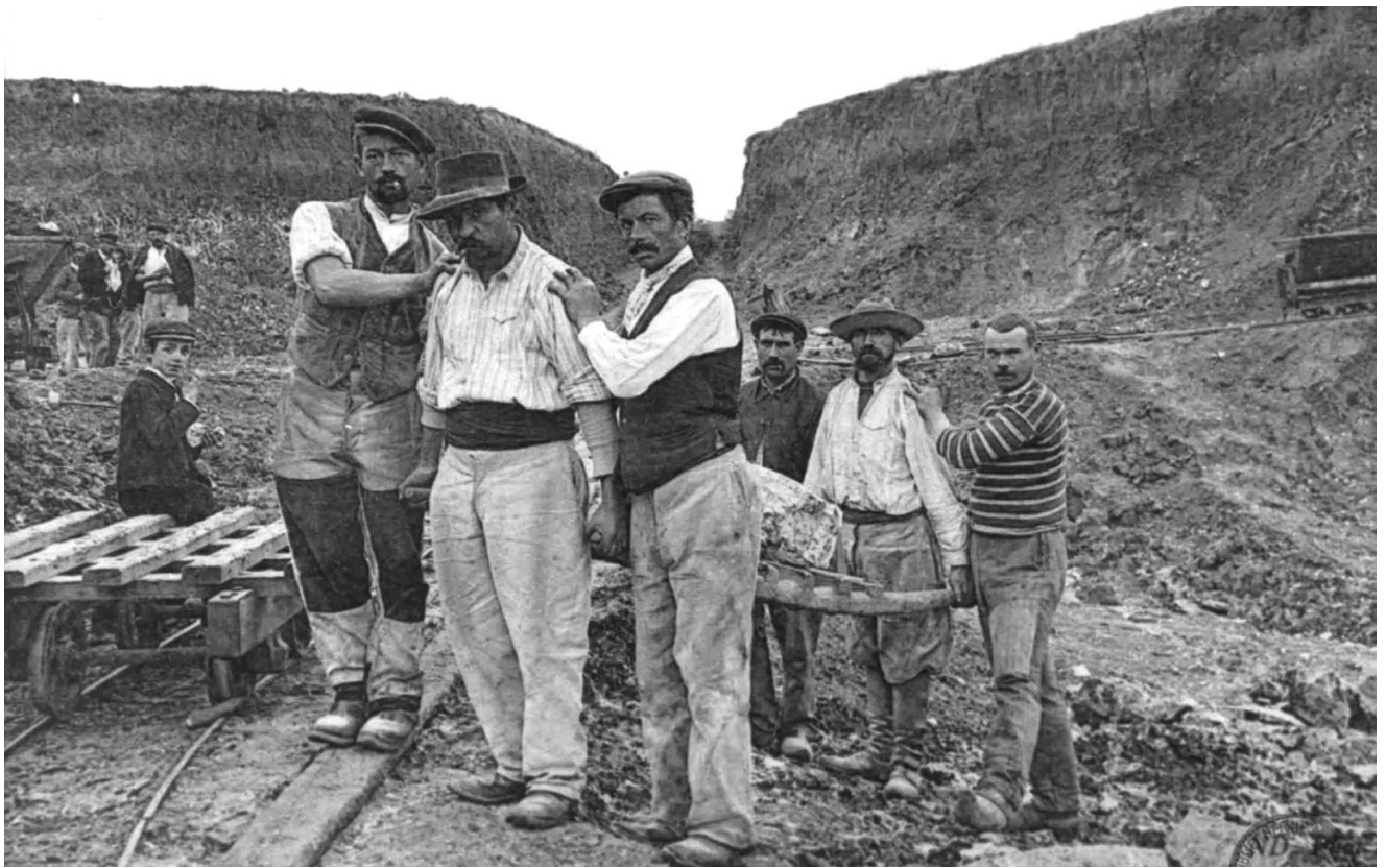
Fig. 9.14 : Evacuation d'un bloc pour meule à bras d'homme. Les hommes de chaque côté des porteurs leur tiennent les épaules pour éviter qu'elles se déboitent du fait du poids de la charge (Document du Syndicat d'initiative de La Ferté sous Jouarre)
