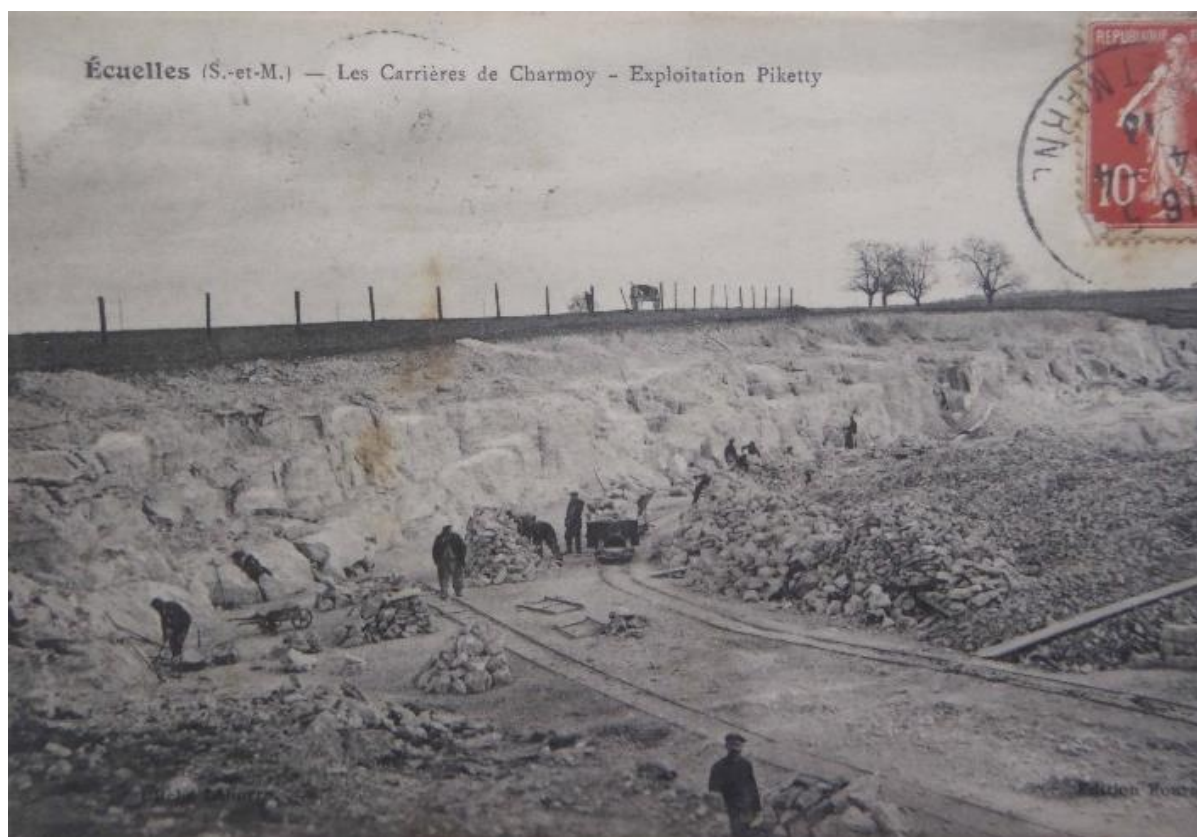
Fig. 7.17 : Vue de la Carrière du Charmoy- Ecuellen- Sté Etablissements Piketty et Fils, vers 1913
