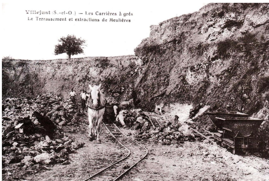
Fig. 3.57: Wagonnets Decauville tirés par des chevaux pour enlever la couverture du gisement de grès (Document Jean Pillot, AFF)
