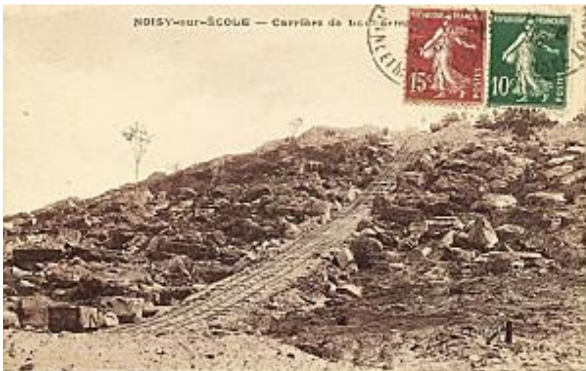
Fig. 3.51: Plan incliné de la carrière de Noisy sur Ecole (Document Didier Roger 2012)
