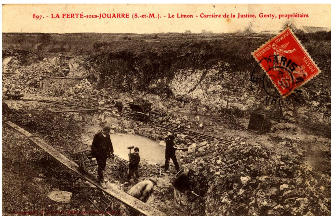
Fig. 9.2 : Carte postale d'une carrière de pierre meulière montrant l'hétérogénéité du gisement et la présence importante d'argile (parties sombres) au-dessus et entre les blocs (Document du Syndicat d'initiative de La Ferté sous Jouarre)
