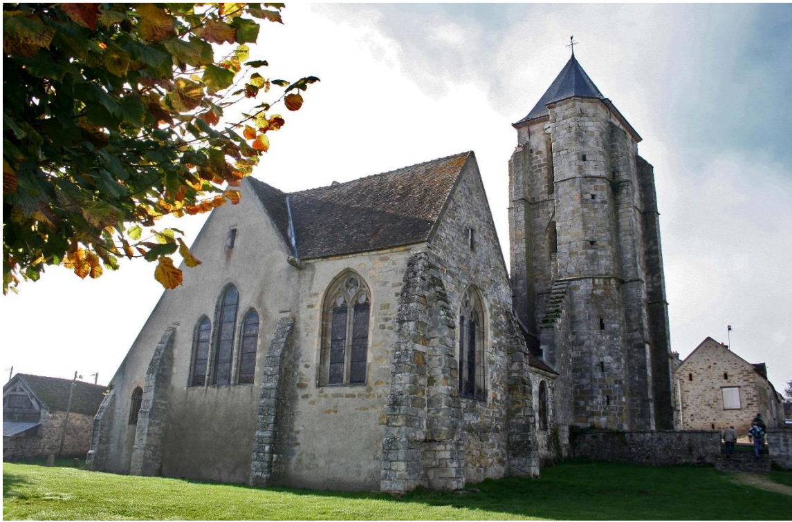
Fig. 3.67 : Eglise de Dormelles (Seine et Marne), construction en grès des 13 ème -14 ème siècles (Document Jean Pillot, AFF)
