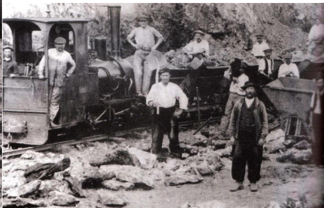
Fig. 3.56: Utilisation manuelle des wagonnets Locomotive à vapeur et wagonnets type Decauville Carrière des Molières vers 1910, opération de découverte (Documents Jean Pillot, AFF)
