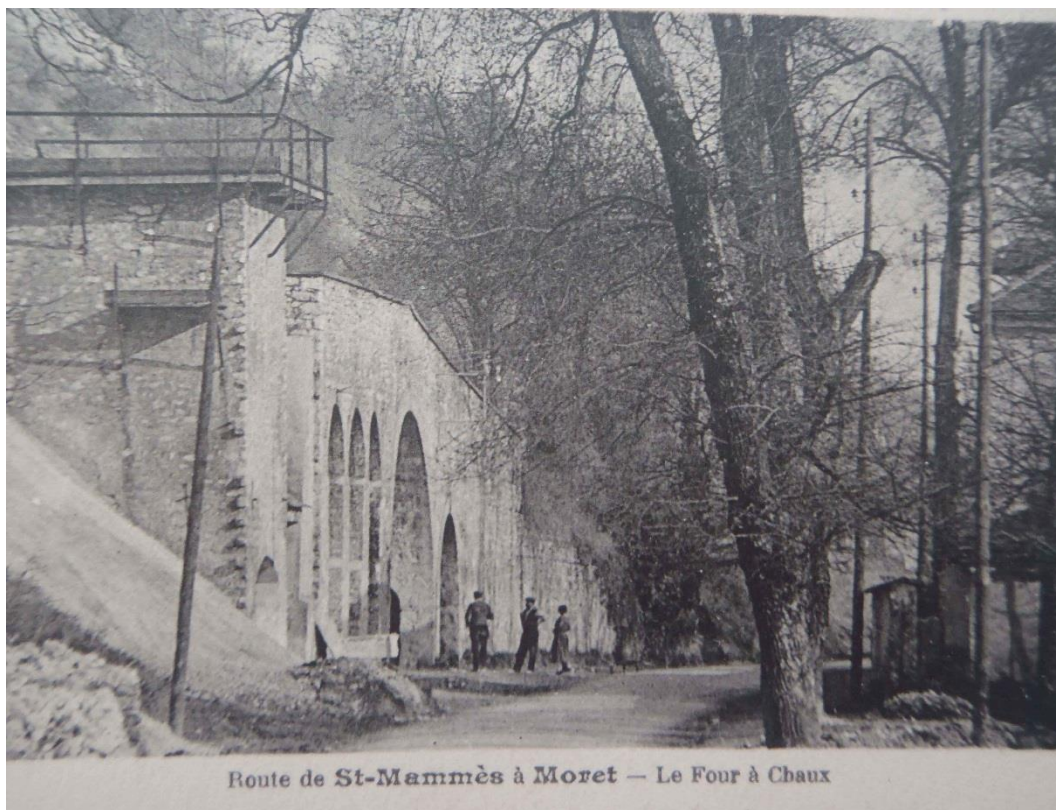
Fig. 6.5 : Vue du four a chaux de Moret en 1935 (Document M Moineaut)
