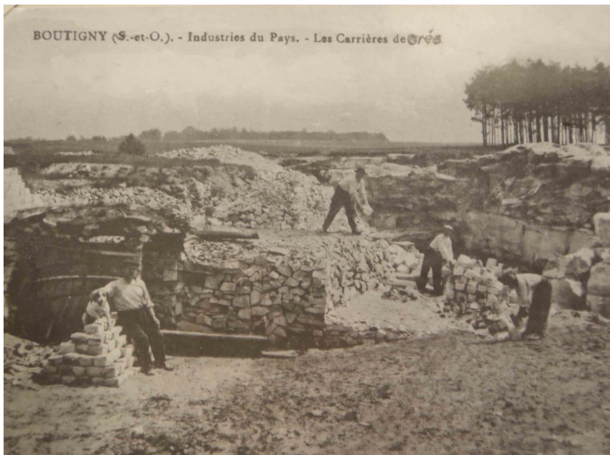
Fig. 3.18 : Vue de la carrière de grès de Boutigny (ancienne Seine et Oise). (Document AD 91 : 26Fi11_29)
