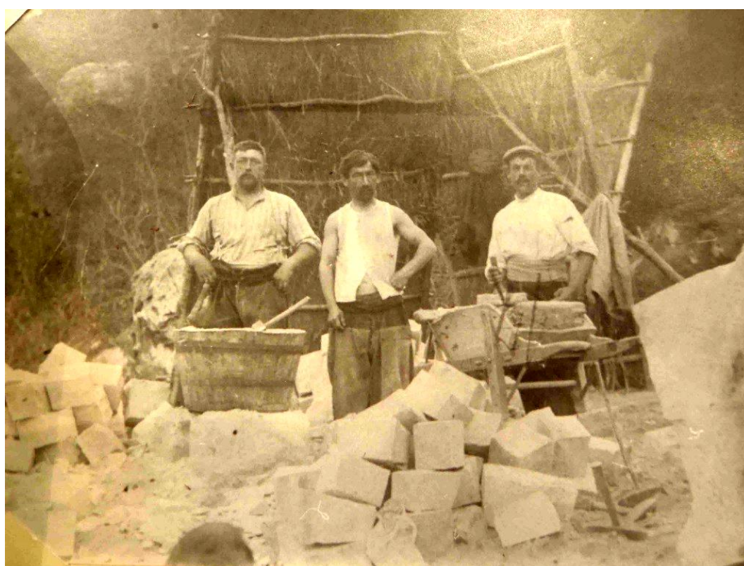
Fig. 3.27 : Vues de la carrière de grès de Boutigny : la taille des pavés (Fichier AD 91 : 26Fi12_24)
