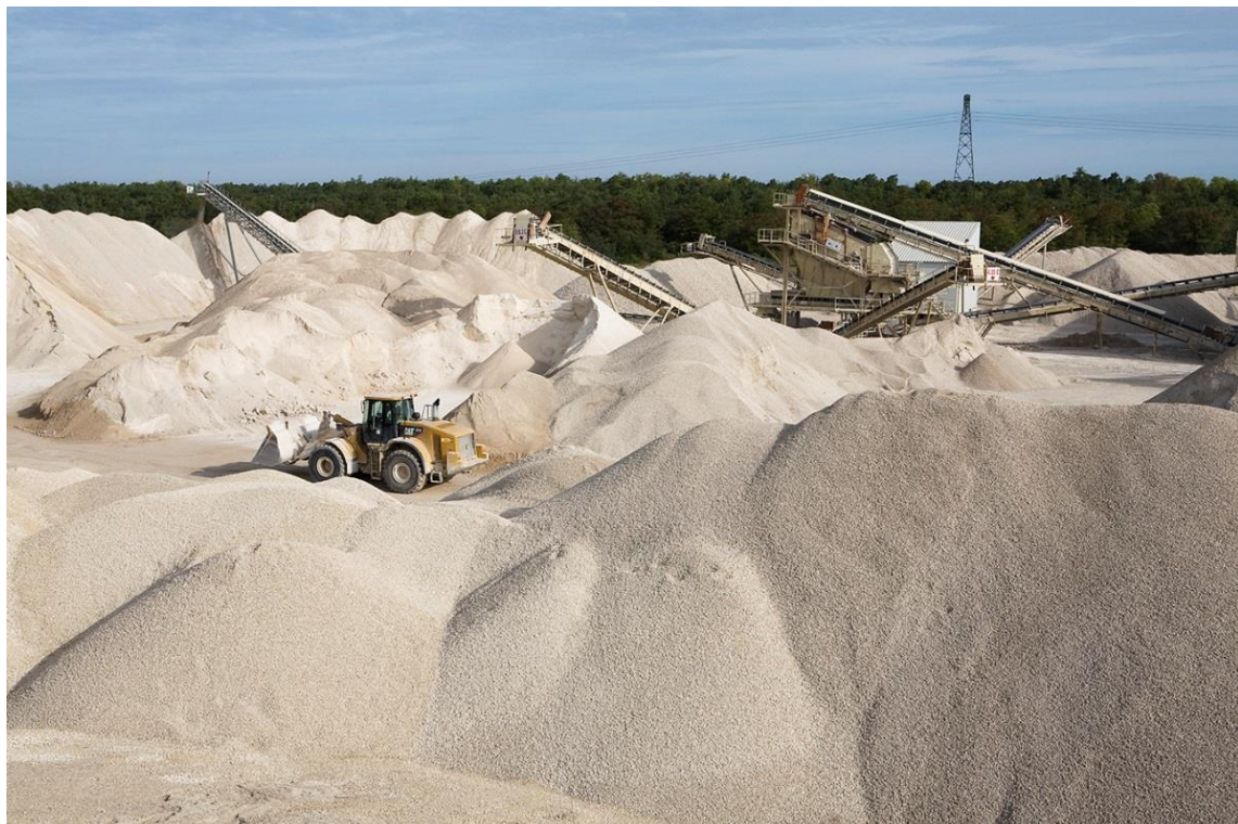
Fig. 5.34 : Installation de traitement et de stockage des granulats (Document SCSL, 2013)
