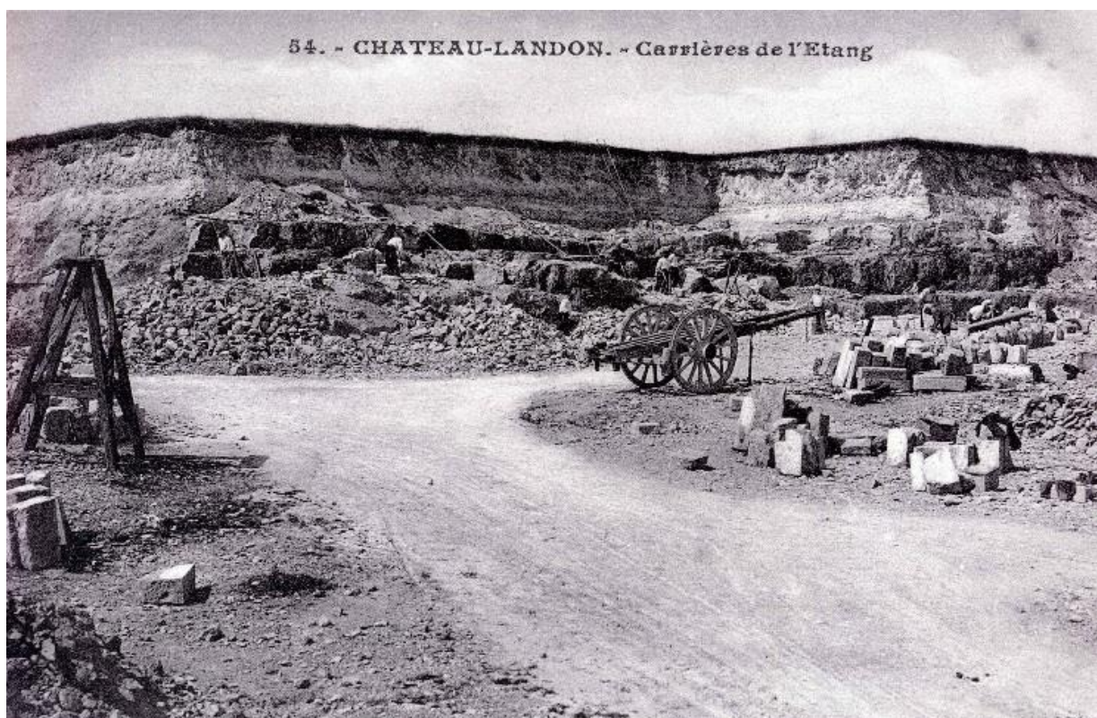
Fig. 5.2 : Carrière de l'Etang à Château-Landon vers 1900: Vue générale de la carrière. La couche de calcaire apparaît en sombre à la base de la falaise, au niveau des ouvriers. Elle repose sous une importante couverture de terrains supérieurs qu'il fallait enlever afin de pouvoir dégager les bancs de calcaire.
