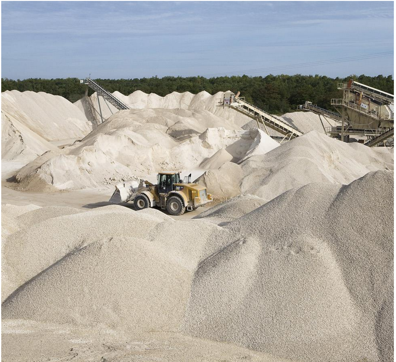
Fig. 7.0 : Installation de traitement et de stockage des granulats calcaires (Document SCSL)
