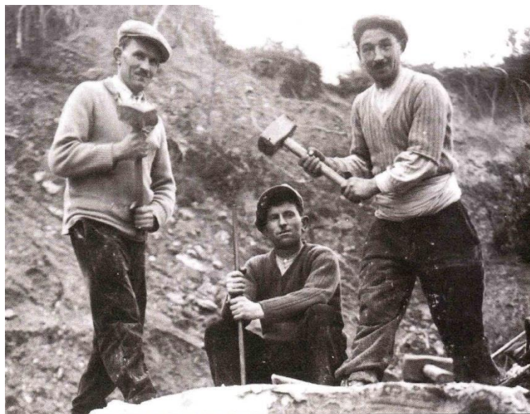
Fig. 3.44: Creusement d'un trou à l'aide d'une barre à mine frappée à la masse pour y placer l'explosif - 1930, Carrière de la Comtesse –Les Molières, Essonne (Document Jean Pillot, AFF)
