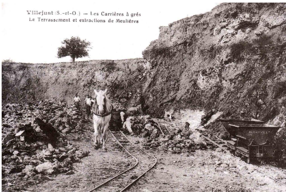
Fig. 9.4 : Extraction de la meulière de la carrière de Villejust (Essonne) ». On voit bien la mécanisation de l'évacuation des blocs avec des wagonnets marqués « Decauville ». Cette meulière formait en fait la découverte des bancs de grès de Fontainebleau, aussi exploités au niveau inférieur. La carte postale date de 1905-1910 (Document J. Pillot, AFF)
