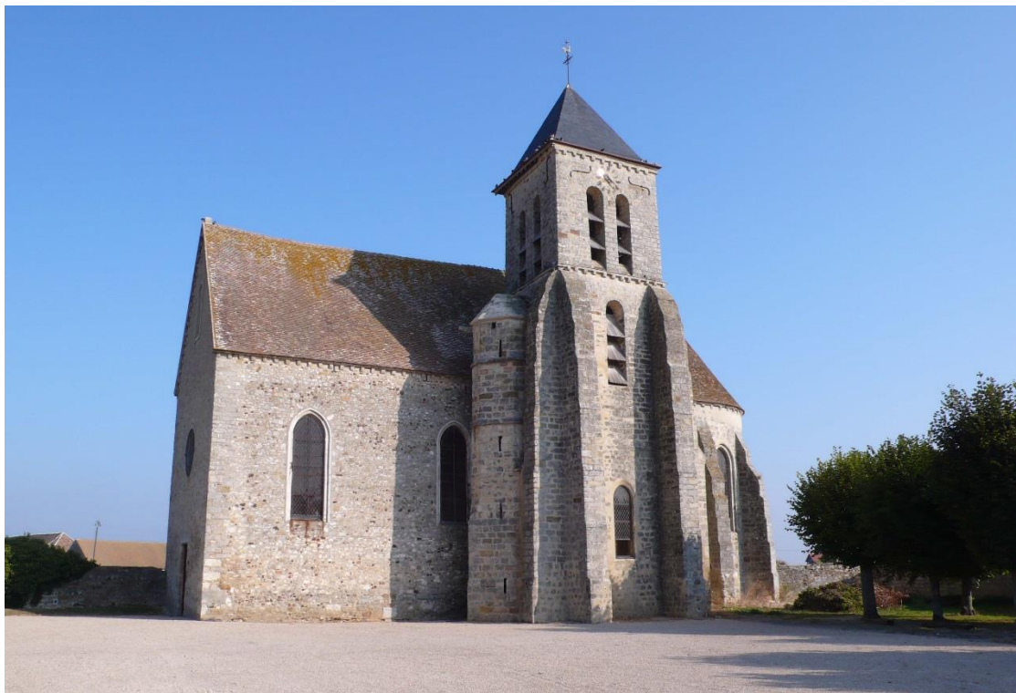
Fig. 3.68: Eglise d'Esmans (Seine et Marne), construction en grès (Document Jean Pillot, AFF)
