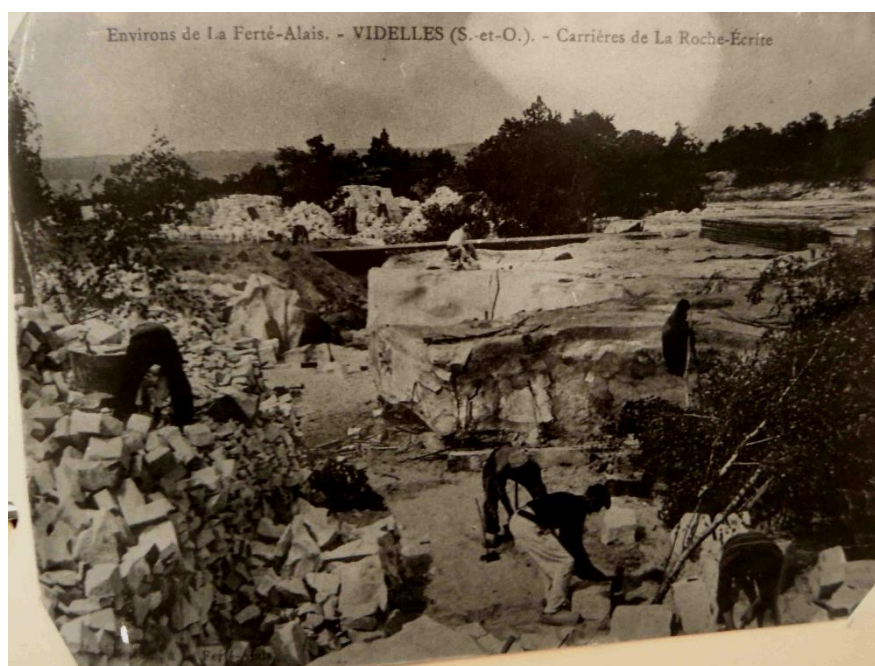
Fig. 3.20 : Vue de la carrière de grès de Boutigny- Videlles (ancienne Seine et Oise). (Document AD 91 : 26Fi100_62)
