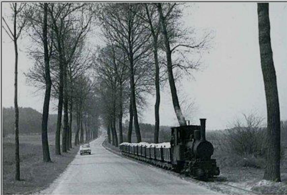
Fig. 4.16 : Train de type Decauville pour le transport du sable vers son site d'expédition ou de traitement (région d'Ormesson ?) (Document Photonature Fontainebleau)
