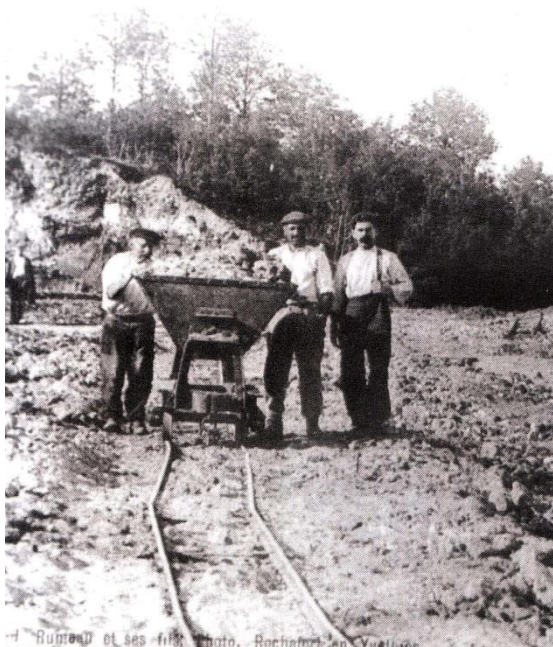
Fig. 3.56: Utilisation manuelle des wagonnets Locomotive à vapeur et wagonnets type Decauville Carrière des Molières vers 1910, opération de découverte (Documents Jean Pillot, AFF)
