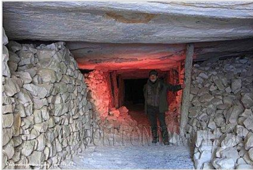
Fig. 4.9: Carrière souterraine de sable, soutènement de la dalle de grès supérieure par empilement de blocs de grès et piliers en bois (Document PhotoNature Fontainebleau)
