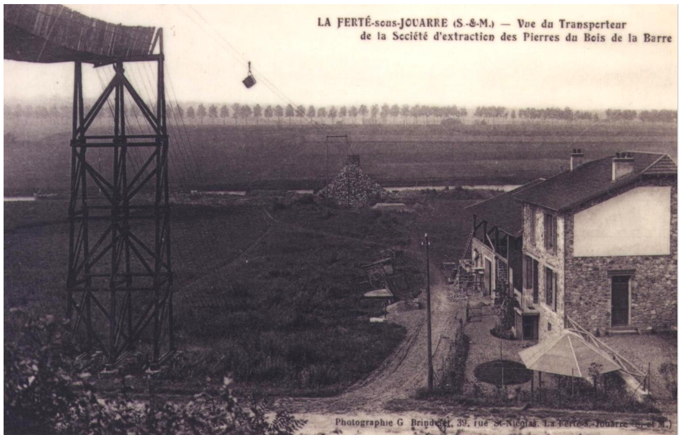
Fig. 9.17 : Vue du transporteur aérien pour l'évacuation des blocs de la carrière de la Sté de La Barre (Document du Syndicat d'initiative de La Ferté sous Jouarre)
