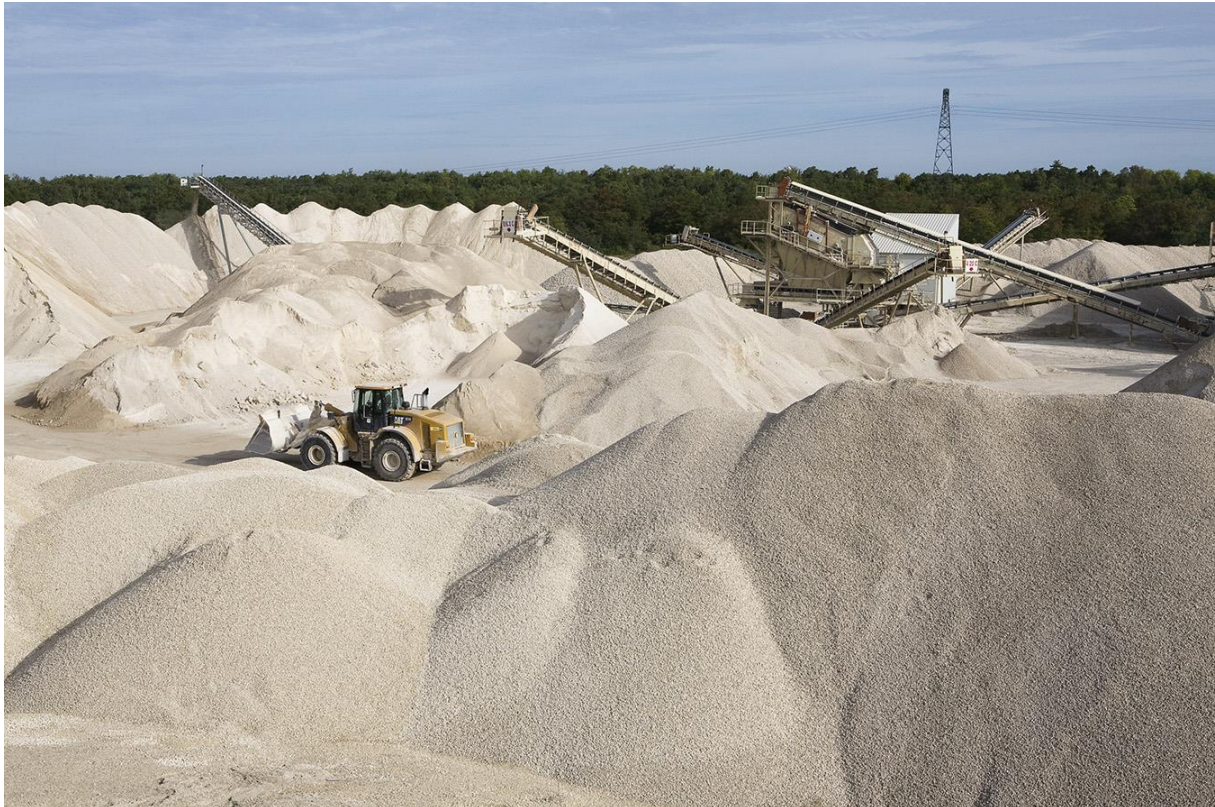
Fig. 7.21 : Installation de traitement et de stockage des granulats calcaires (Document SCSL)
