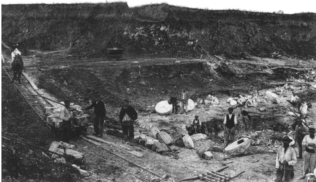
Fig. 9.12 : Vue d'une carrière de meulière avec pré-façonnage des blocs pour meules sur le site et évacuation des blocs par wagonnet sur plan incliné (Document du Syndicat d'initiative de La Ferté sous Jouarre)
