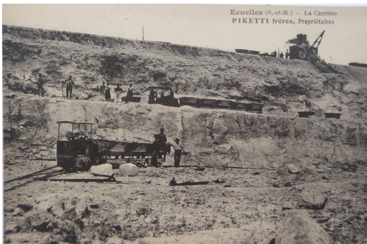
Fig. 7.18 : vue de la Carrière d'Écuellen- Sté Piketty Frères vers 1925. Noter la mécanisation : pelle mécanique à godets en haut pour la découverte et trains sur voie ferrée étroite sur les gradins pour le transport des blocs)
