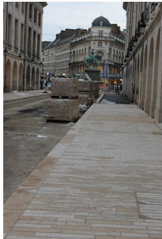
Fig. 5.33: pavage de voie du tramway à Orléans et réalisation de trottoirs en pierre de Souppes (Document SCSL, 2013)
