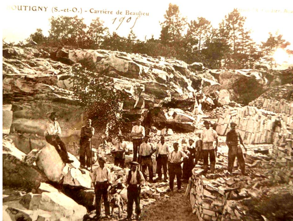
Fig. 3.3 : Vues de la carrière de grès de Boutigny- Beaulieu (ancienne Seine et Oise) , 1905 : le gisement de grès se situe directement à la surface du terrain ce qui permet son exploitation directe sans déblaiement important (Document AD 91 : 26Fi12_11)
