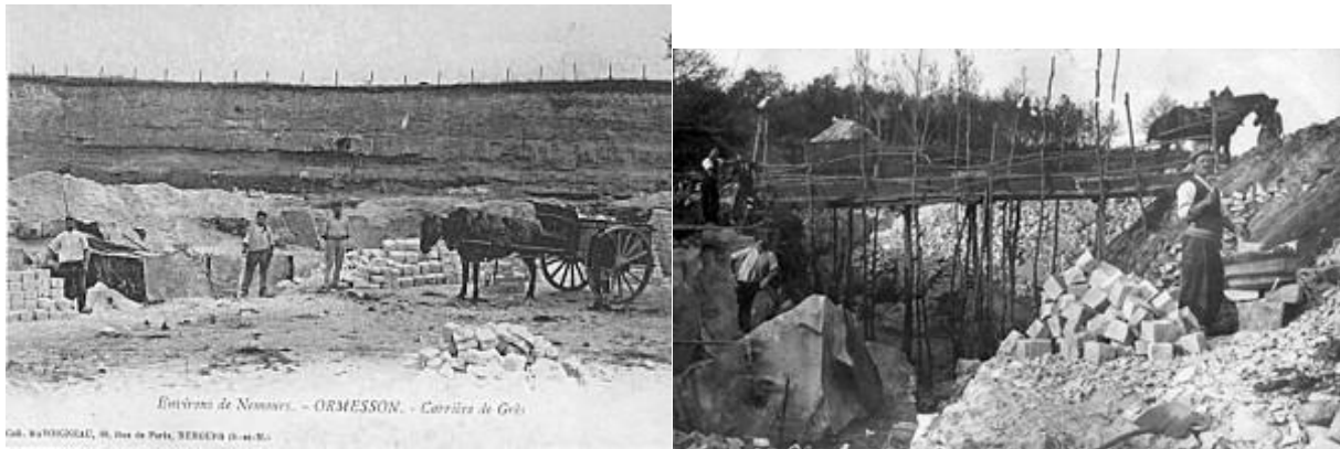
Fig. 3.49: Le transport de pavés de grès par tombereau et wagonnet, tirés par des chevaux (Document Didier Roger, 2012)
