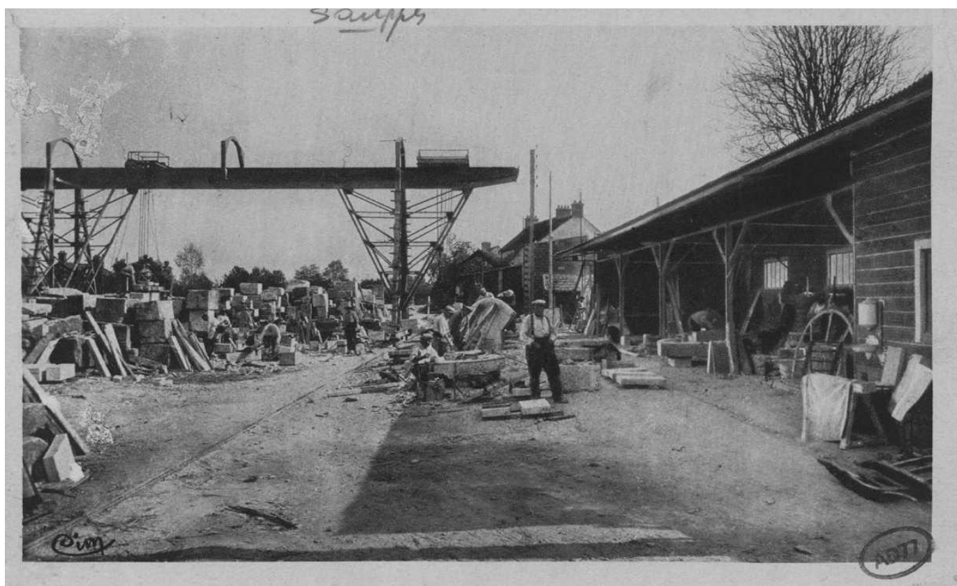
Fig. 5.20 : Mécanisation de la manutention des blocs sur le chantier de taille de Souppes : utilisation d'un pont de levage (Document AD 77 : 2F1 19017)
