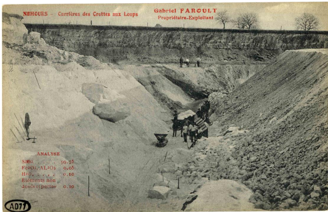
Fig. 4.12.2 : Vues de la carrière de sables de Fontainebleau de La Crotte au Loups vers 1900. Noter l'importance de la couverture avant d'atteindre la couche de sable et les wagonnets de transport tirés par des chevaux (Document AD 77 : FRAD077_2Fi22826_600.tif)
