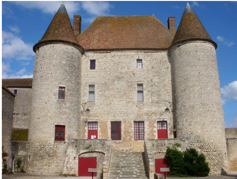
Fig. 8.12 : Château de Nemours et son toit en tuiles de Bezanleu (Source : www.nemours.fr/chateau-de-nemours )
