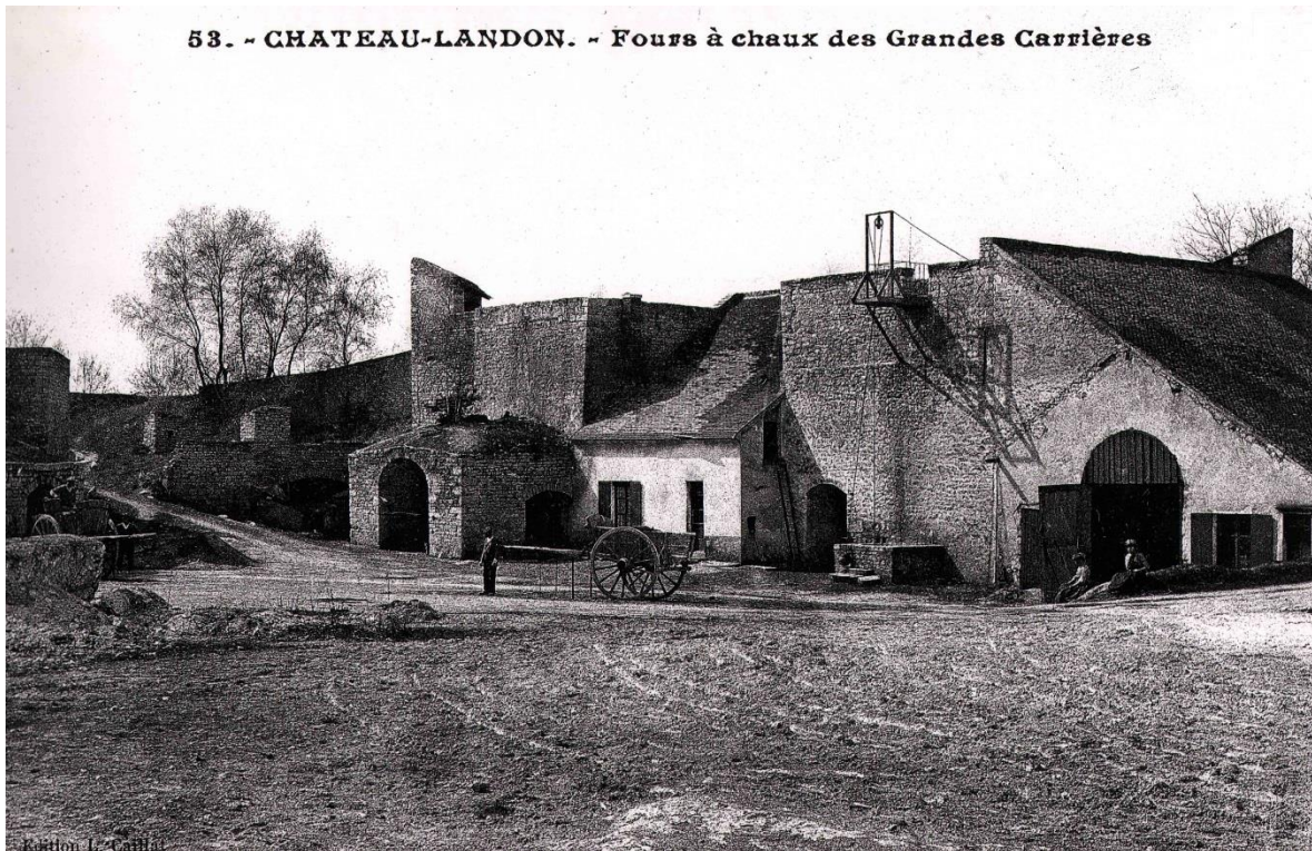
Fig. 5.29 : Ancien four à chaux de Château-Landon : ruines de fours à chaux au pied de la carrière de l'Enfer au départ de l'ancien chemin de Souppes à Château-Landon.
