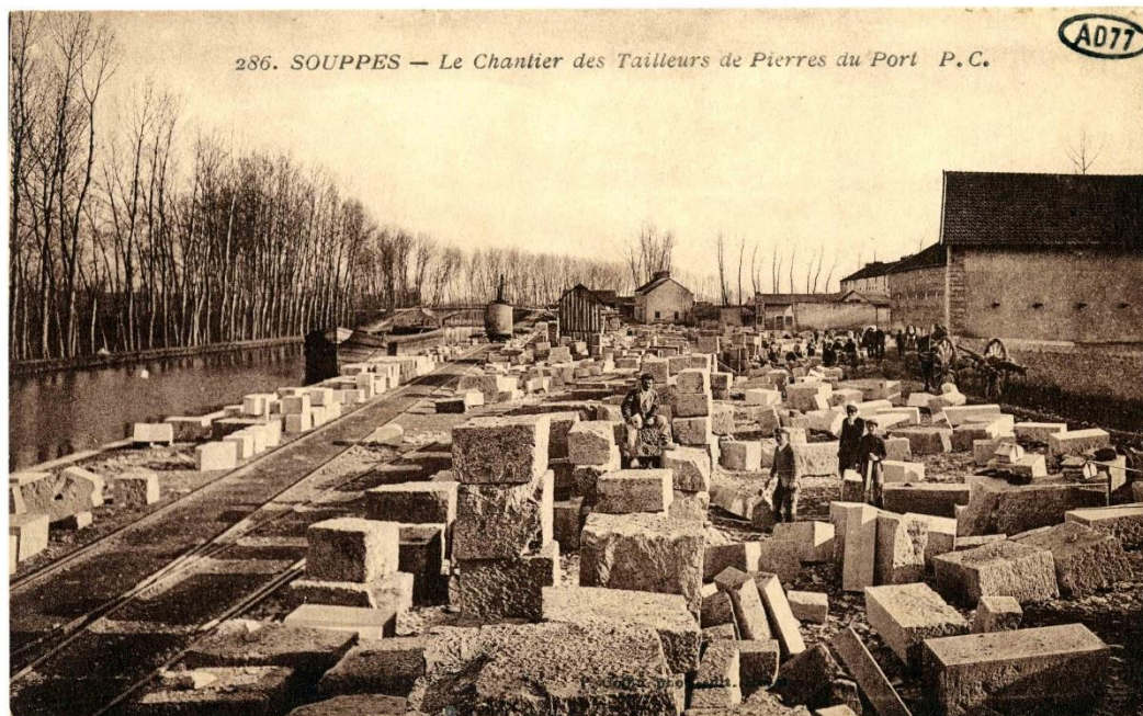
Fig. 5.19 : Chantier de taille au Port de Souppes sur Loing (Document AD 77: 2FI 22872)
