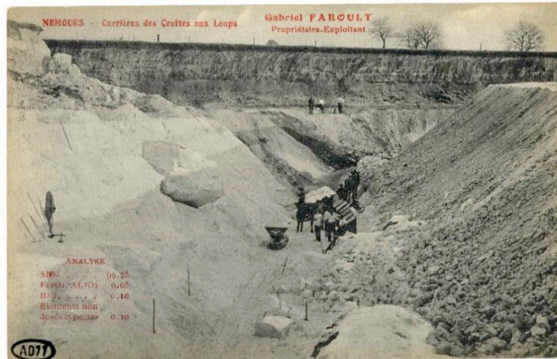
Fig 4.10.2: Vues de la carrière de sables de Fontainebleau de La Crotte au Loups vers 1900. Noter l'importance de la couverture avant d'atteindre la couche de sable et les wagonnets de transport tirés par des chevaux (Document AD 77 : FRAD077_2Fi22826_600.tif)
