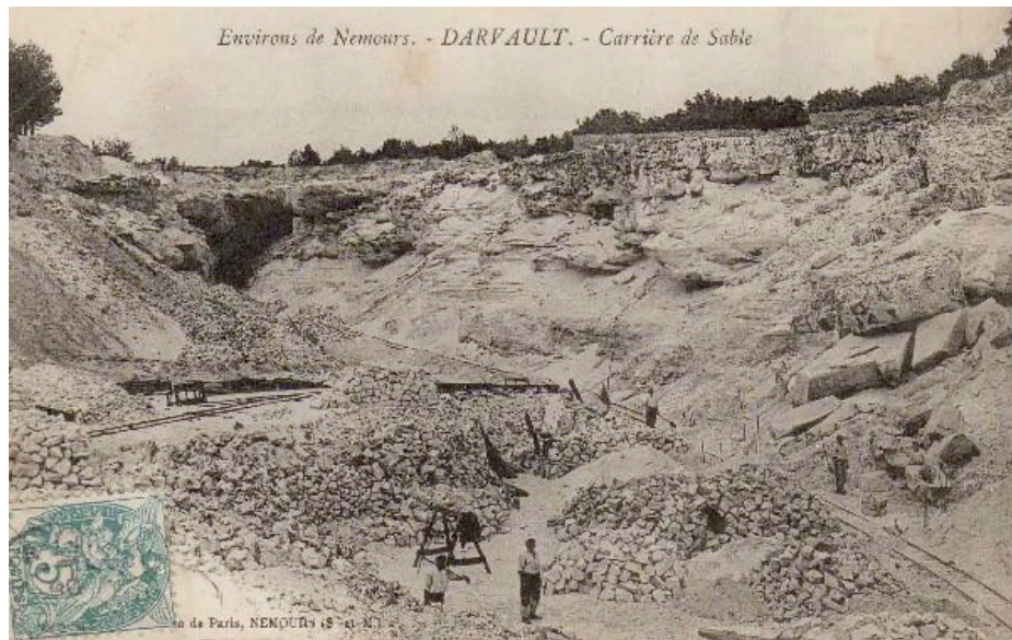
Fig 4.6: Vue des carrières de sables et grès de Fontainebleau de Darvault vers 1900. Dans le coin gauche en haut, entrée de la carrière souterraine, sous la dalle de grès. On note aussi l'utilisation de rails à
