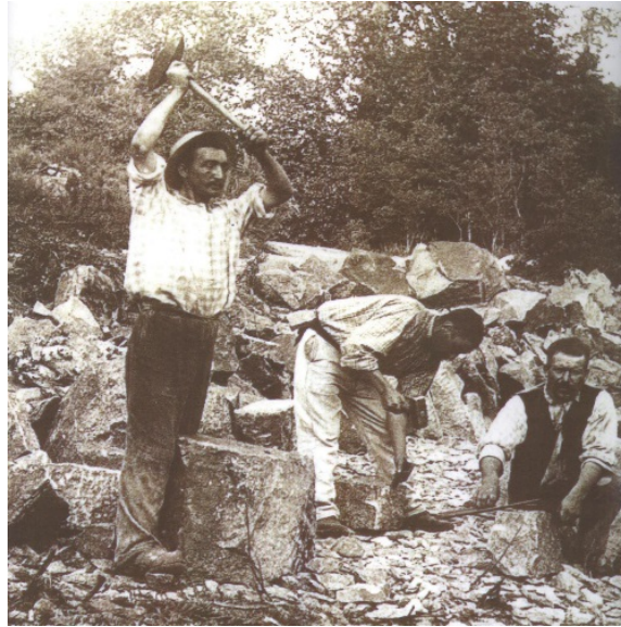
Fig 9.12: Vue du travail en carrière avec le « têtu »
