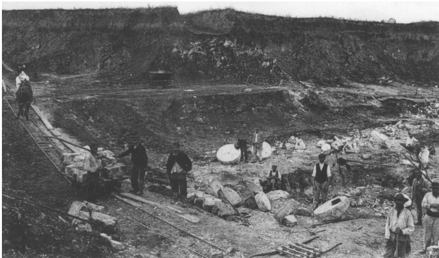
Fig 9.11: Vue d'une carrière de meulière avec préfaçonnage des blocs pour meules sur le site et évacuation des blocs par wagonnet sur plan incliné (Document du Syndicat d'initiative de La Ferté sous Jouarre)
