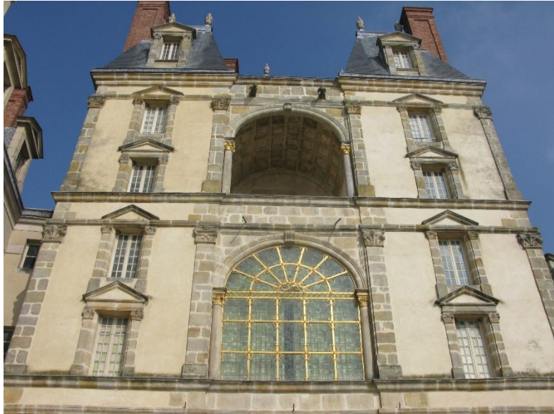
Fig 3.63 : Façade de la Porte Dorée du Château de Fontainebleau : édifée à partir de 1528, on remarque l'utilisation du grès pour les chaînages d'angle à chaque extrémité de la façade, pour les pilastres et les corniches (parties foncées de la façade) (Document : Prof. Patrick Dubreucq : travail des élèves de Seconde-Lycée Blanche de Castille , mars 2012
