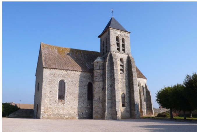
Fig 3.64 : Eglise d'Esmans (Seine et Marne) : construction en grès (Document Jean Pillot, AFF)
