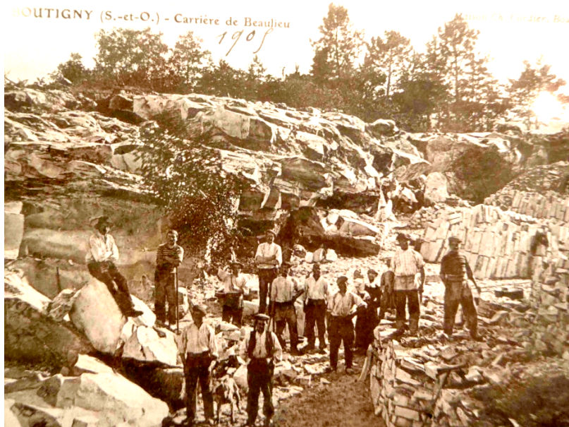
Fig 3.15 : Vues de la carrière de grès de Boutigny- Beaulieu (ancienne Seine et Oise) , 1905 : le gisement de grès se situe directement à la surface du terrain ce qui permet son exploitation directe sans déblaiement important (Document AD 91 : 26Fi12_11).
