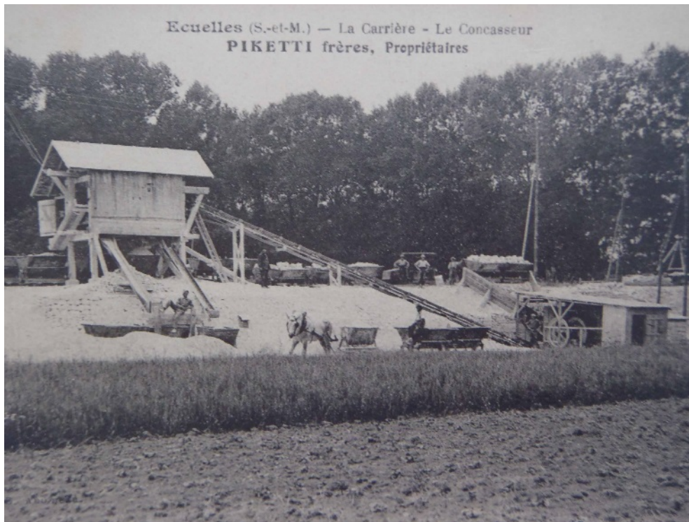
Fig 7.6 :: vue de la Carrière d'Ecuellen- Sté Piketty Frères vers 1925 : le concasseur et son système d'alimentation
