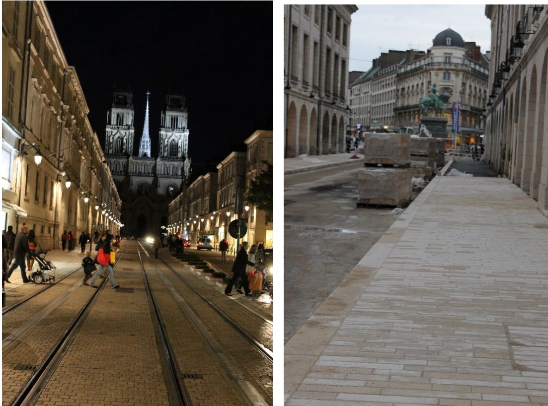
Fig 6.70: pavage de voie du tramway à Orléans et réalisation e trottoirs en pierre de Souppes (Document SCSL, 2013)
