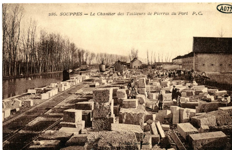
Fig 5.14 : Chantier de taille au Port de Souppes sur Loing (Document AD 77: 2FI 22872)
