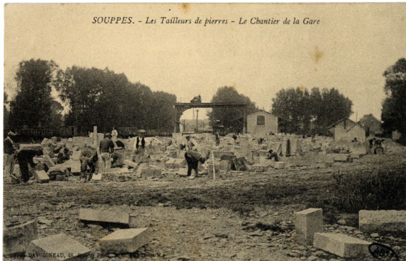
Fig 5.13 : Chantier de taille à la gare de Souppes sur Loing (Document AD 77: 2FI 22871)
