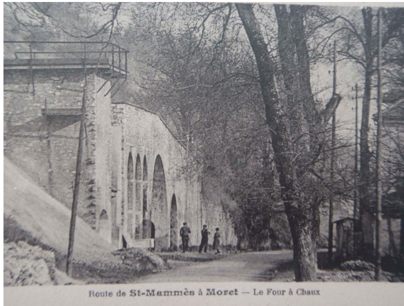
Fig 6.5 : Vue du four a chaux de Moret en 1935 (Document M Moineaut)
