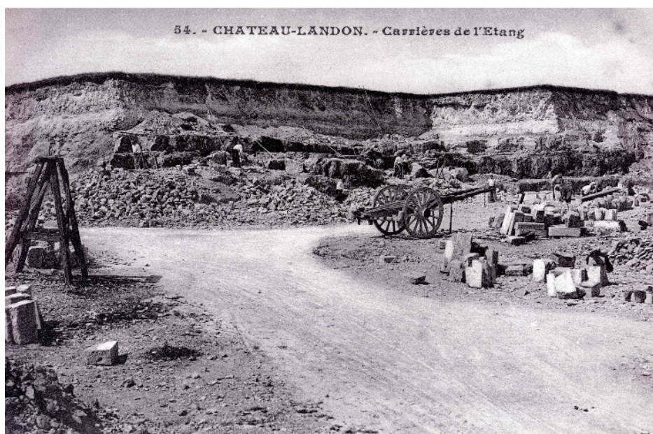
Fig 5.12 : Carrière de l'Etang à Château Landon vers 1900: Vue générale de la carrière- au 1er plan blocs taillés et charrette de transport, au 2ème plan : fronts de taille et ouvriers
