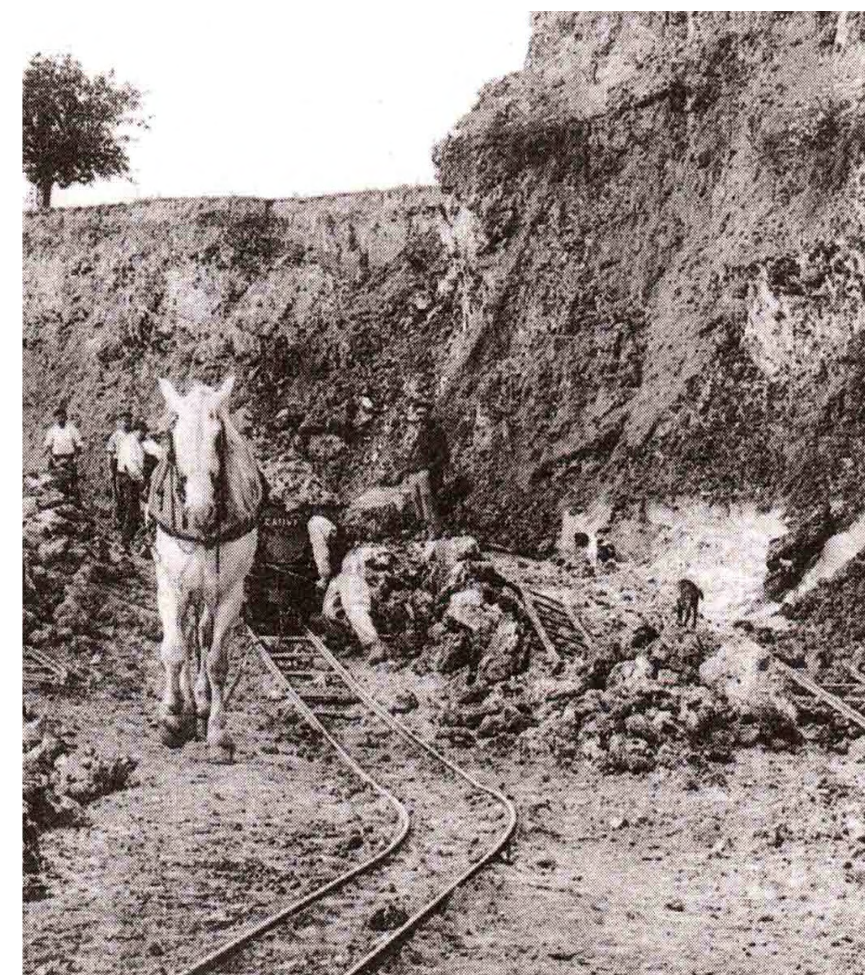
EXTRACTION DE LA MEULIÈRE DE LA CARRIÈRE DE VILLEJUST (ESSONNE) EN 1905-1910. (DOCUMENT AIMABLEMENT FOURNI PAR J. PILLOT, AFF)
