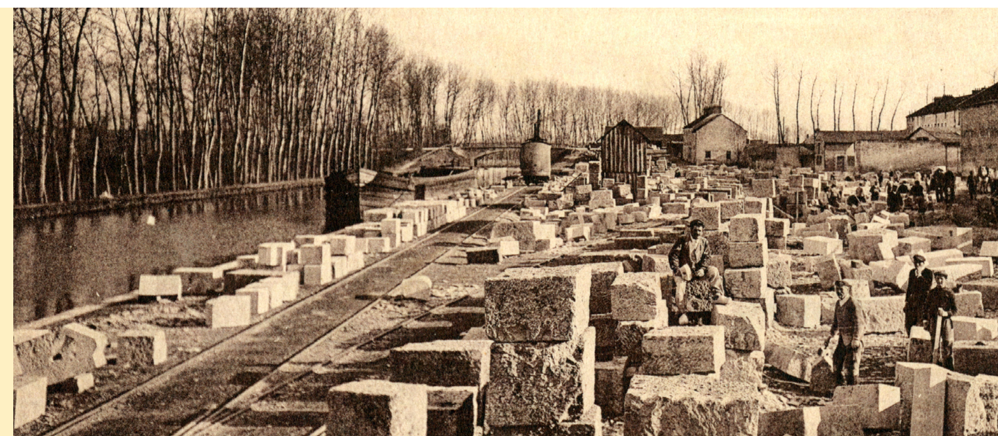
CHANTIER DE TAILLE AU PORT DE SOUPES SUR LOING
