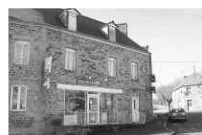
Le commerce du bourg subira quelques travaux de nettoyage et peinture durant deux semaines avant de rouvrir le samedi 21 mars.
